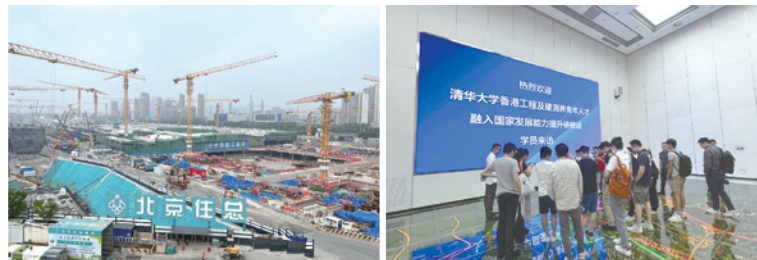
位於通州區的北京城市副中心站綜合交通樞紐工程
